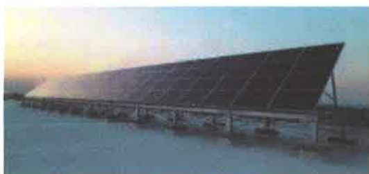
公共施設への太陽光パネルの設置
