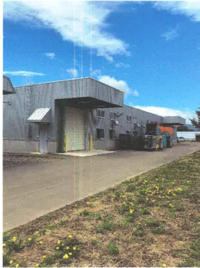
【貯蔵選別施設】
