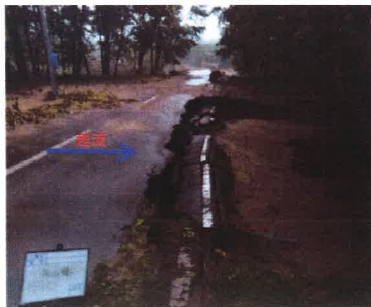
写真① 復旧起点→終点方向
