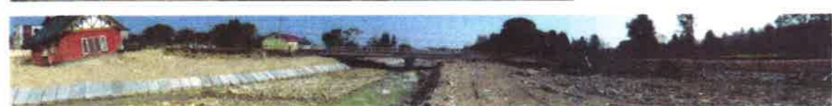
写3-上流側の全景（河川仮応急後）
