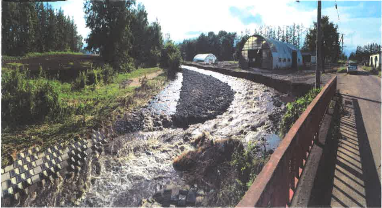
羽帯幹線明渠排水路 南4線道路から上流側に向かって撮影 (2016.9.2)
