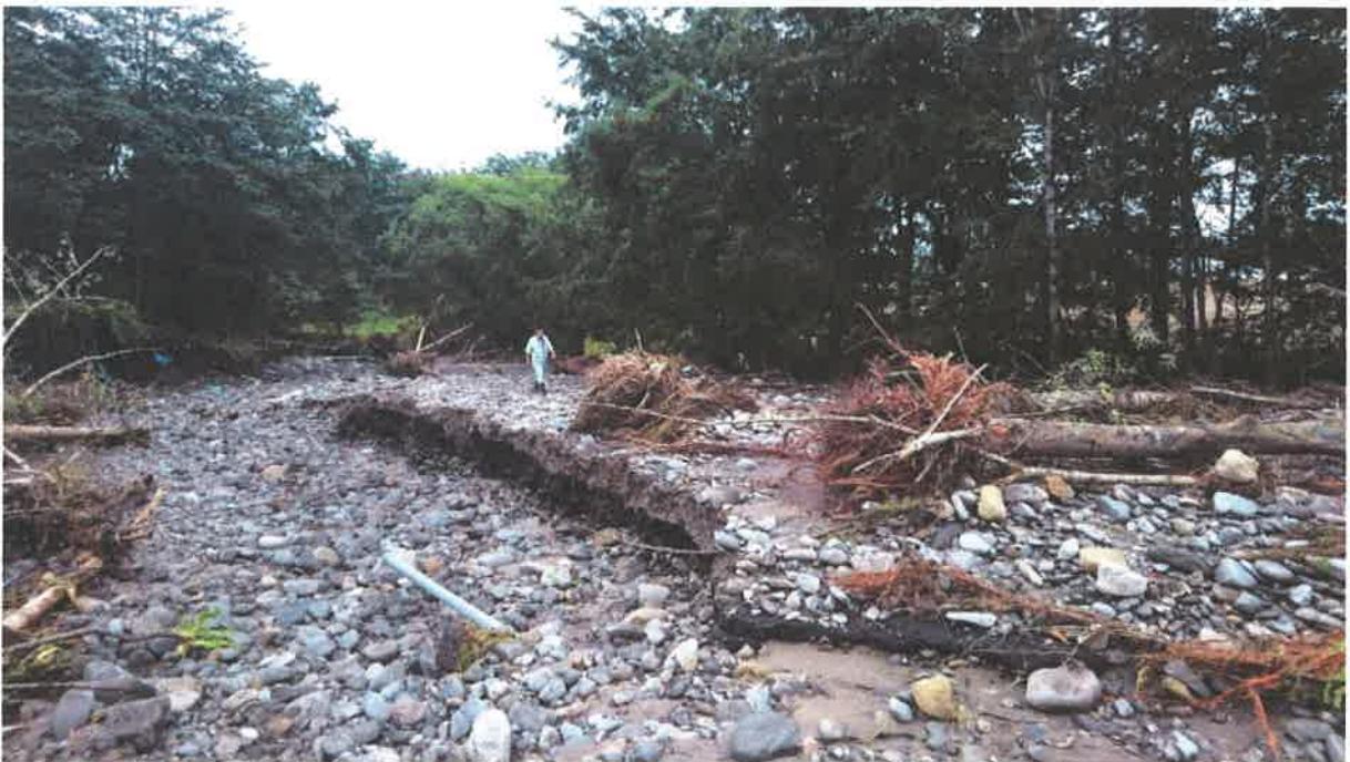
羽帯幹線明渠排水路 南4線・南5線道路間写真 下流側に向かって撮影 (2016.9.4)
