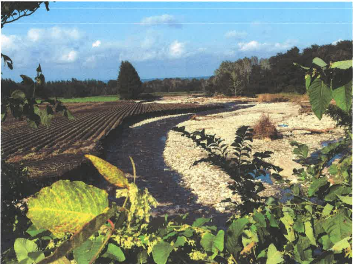
羽帯幹線明渠排水路 南4線道路から下流側に向かって撮影 (2016.9.2)
