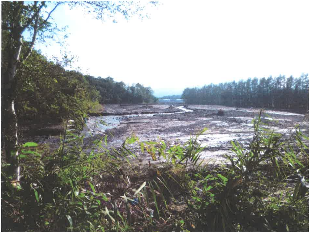
羽帯幹線明渠排水路 南3線から上流側に向かって撮影 (2016.9.2)
