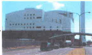
くりりんセンター(一般廃棄物中間処理施設)
