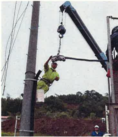
高压ケーブルによる応急送電
