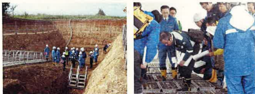
(トレンチ調査)
