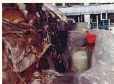
ケーシング内部の状況
