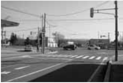
国道274号線と国道38号線の交差箇所
