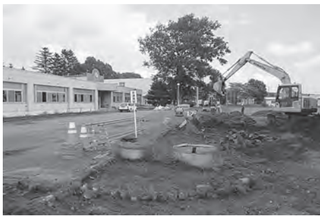
福祉館として活用するため、改修工事を行っている旧熊牛小学校。
