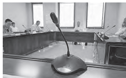
第1委員会室の音響設備も更新。
