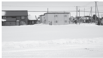
高齢者向け住宅の建設が予定されている、公営住宅跡地
