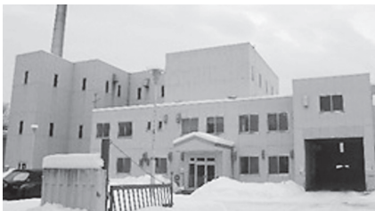
供用開始から24年が経過し、耐用限界に近づいている清掃センター
