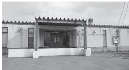
老朽化により、学校プールとしての建替えが決まった町民水泳プール
