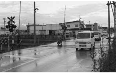
10号道路の踏切は歩行者も多く、 危険な箇所である。
