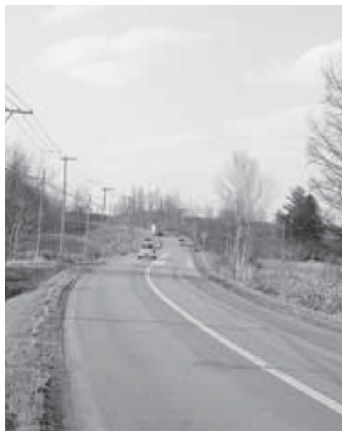
交通量が多い清水8線道路
