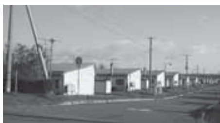
町営住宅は入居者への調査等を行い修繕している
