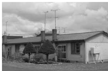
建て替えが検討されている清和団地
