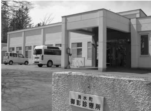
診察棟と入院病棟の改修工事を行う御影診療所
