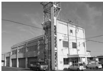
今後、建替事業が進められる清水消防庁舎。
