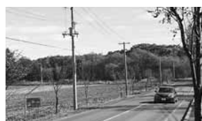
清水羽帯間道路にエゾヤマザクラの補植工事を実施。
