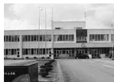
清水小学校の改修工事は、6月から始まる予定で、内装や外構工事が実施される
