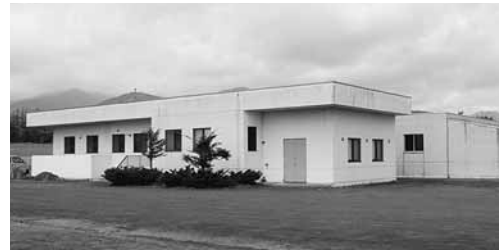
第1・第2浄水場では、町民約6,000人分の水道水をまかっている。
