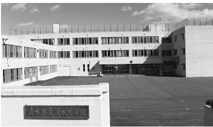
耐震化も含めた清水中学校の大規模改修工事が平成27年度に予定されている
