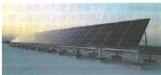
公共施設への太陽光パネルの設置
