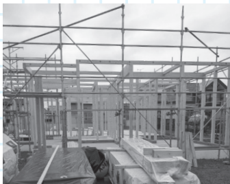
町内に建築中の新築住宅
