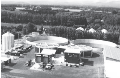
美蔓バイオガスプラント
