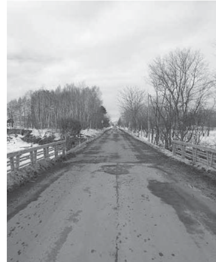
1月10日に仮復旧工事が完了し、通行が可能となった町道清水基線道路(新錦橋)
