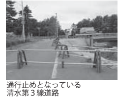
通行止めとなっている清水第3線道路
