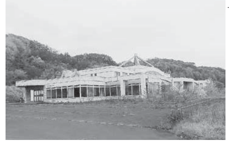
道のりを示す看板（上）と休業中の温泉施設（下）
