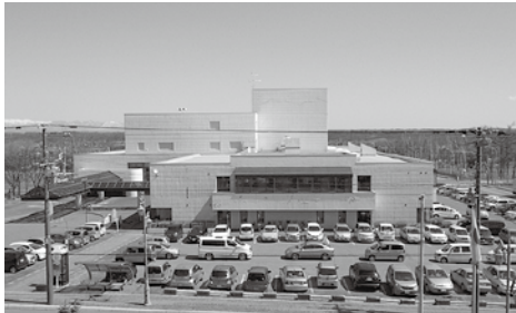
大規模な耐震改修工事や施設設備の更新等を行う清水町文化センター(昭和55年開館)
