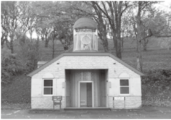
改修前の清水公園カリヨントイレ (平成5年設置)
