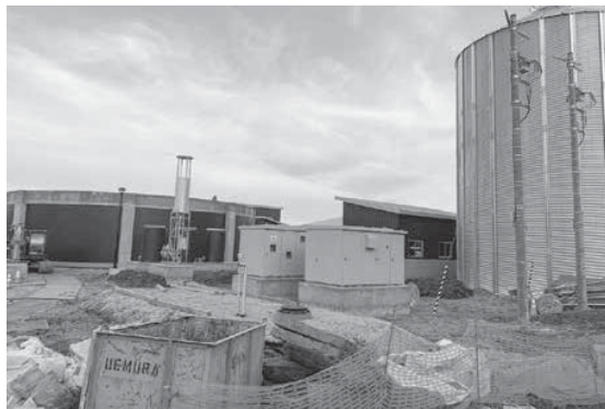
建設中のバイオガスプラント（美蔓）
