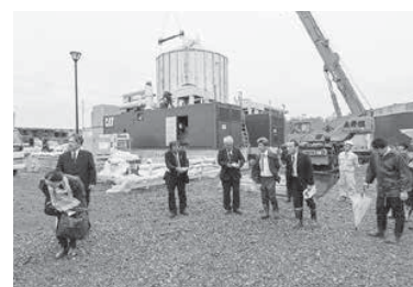
建設中のバイオガスパラントを視察
