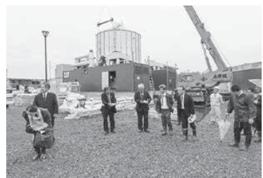
建設中のバイオガスパラントを視察
