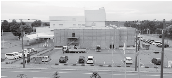
改修工事中の文化センター（7月24日撮影）
