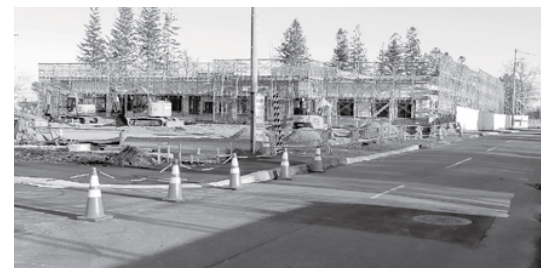
建設中の保育施設と周辺道路
