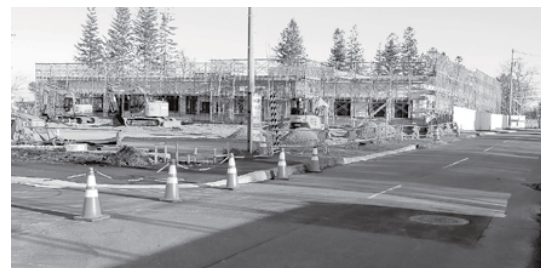
建設中の保育施設と周辺道路
