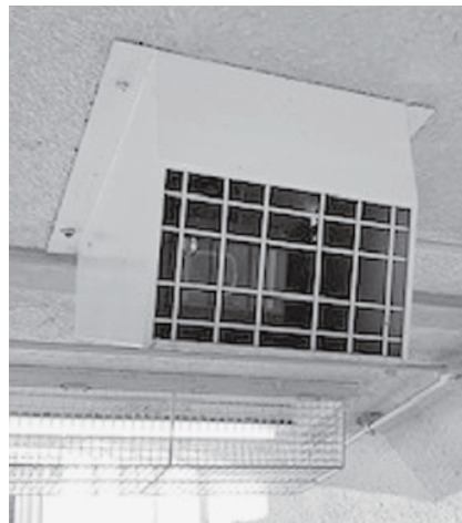
清水小学校通学路の地下歩道に設置されている防犯カメラ
