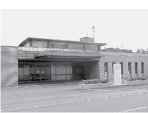
内部改修を行うデイサービスセンター
