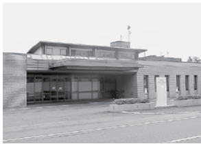
内部改修を行うデイサービスセンター
