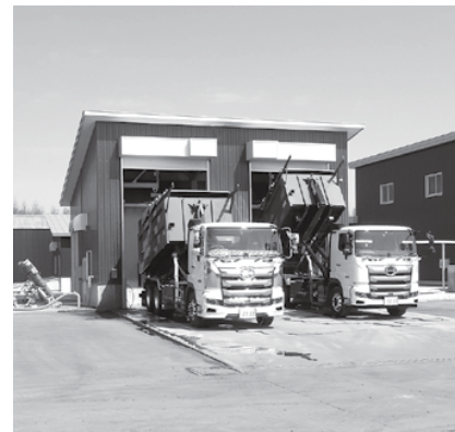
昨年稼働した美蔓バイオガスプラント（牛のふん尿の搬入口）
