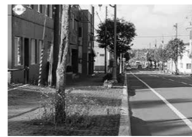
駅前のインターロッキング
