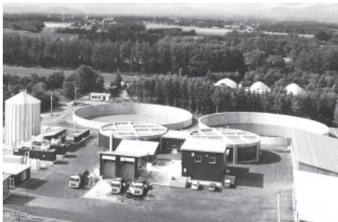
美蔓バイオガスプラント
