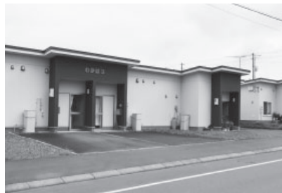
わかば公営住宅
