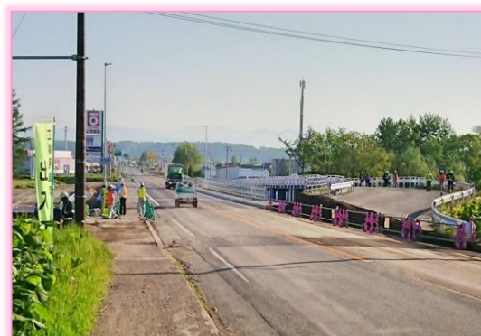
台風 10 号によって崩壊した清美橋
