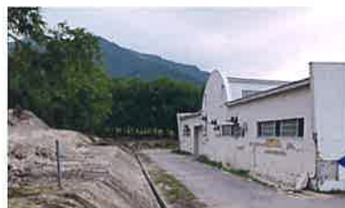
《円山浄水場 復旧工事》
