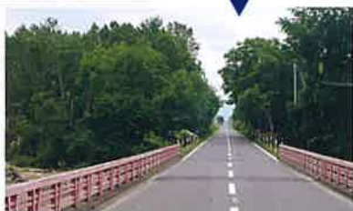
《新錦橋 仮復旧工事》
