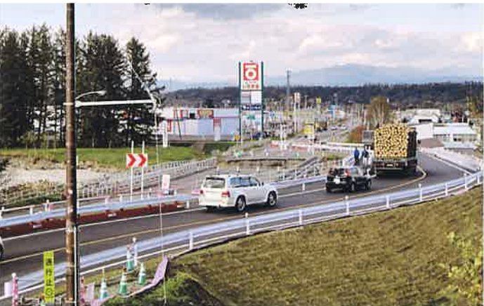
平成28年10月14日 国道38号線 清見橋(仮橋) 開通
