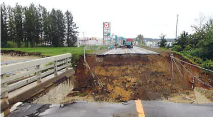
平成28年9月5日 国道38号線 清見橋
