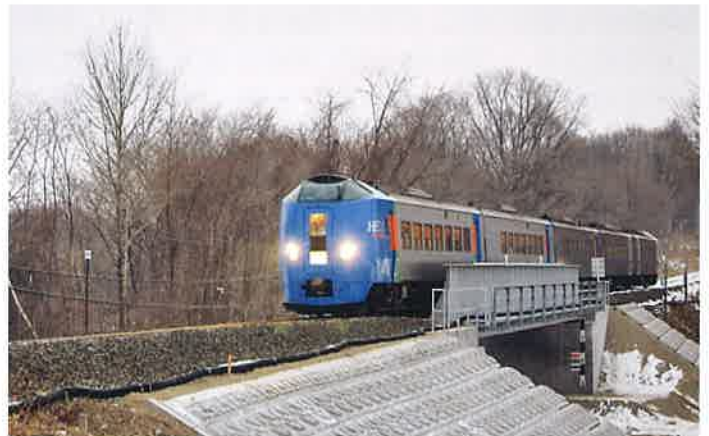
平成28年12月22日 JR根室本線ペケレベツ川橋りょう 開通
