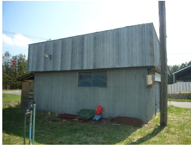
建物B棟 外観
