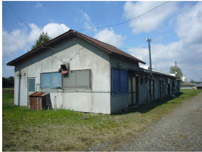
建物A棟 外観
