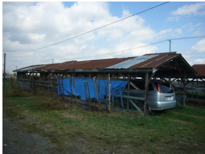
建物C棟外観
