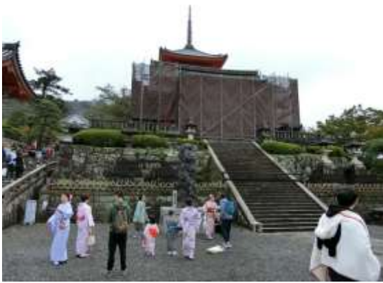
【今しか見られない工事中の様子】
