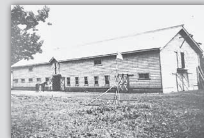
建設当時の十勝開墾株式会社農場畜舎 (ビート資料館提供)
