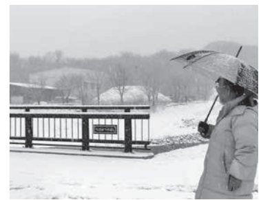
12月 平成28年台風10号で被災したペケレベツ橋が開通
